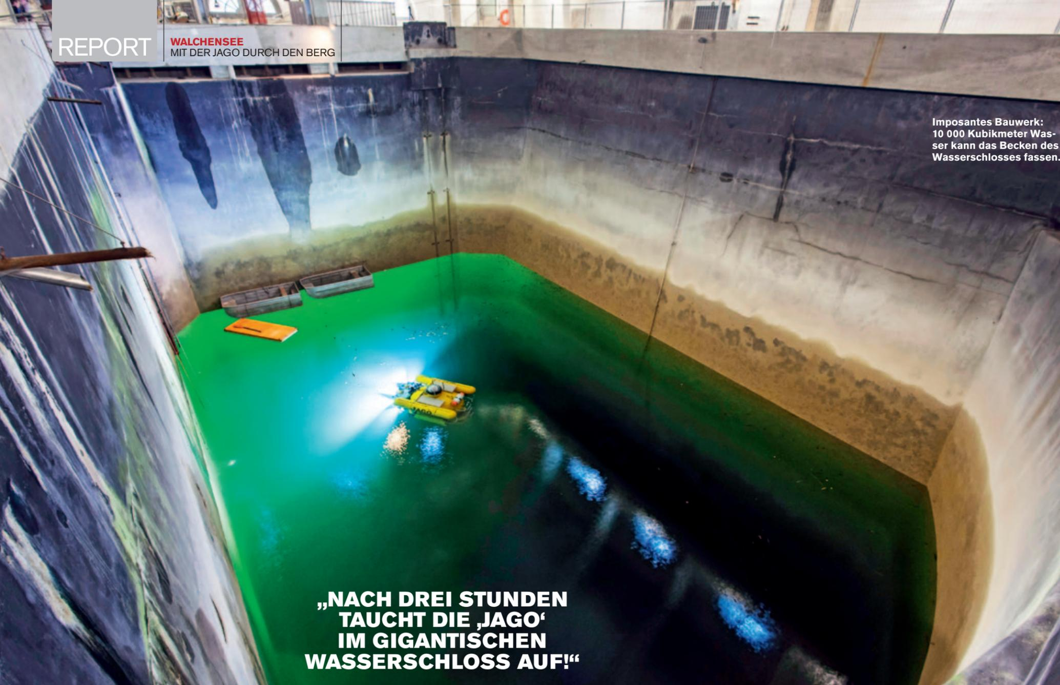
Imposantes Bauwerk: 10 000 Kubikmeter Wasser kann das Becken des Wasserschlosses fassen.
