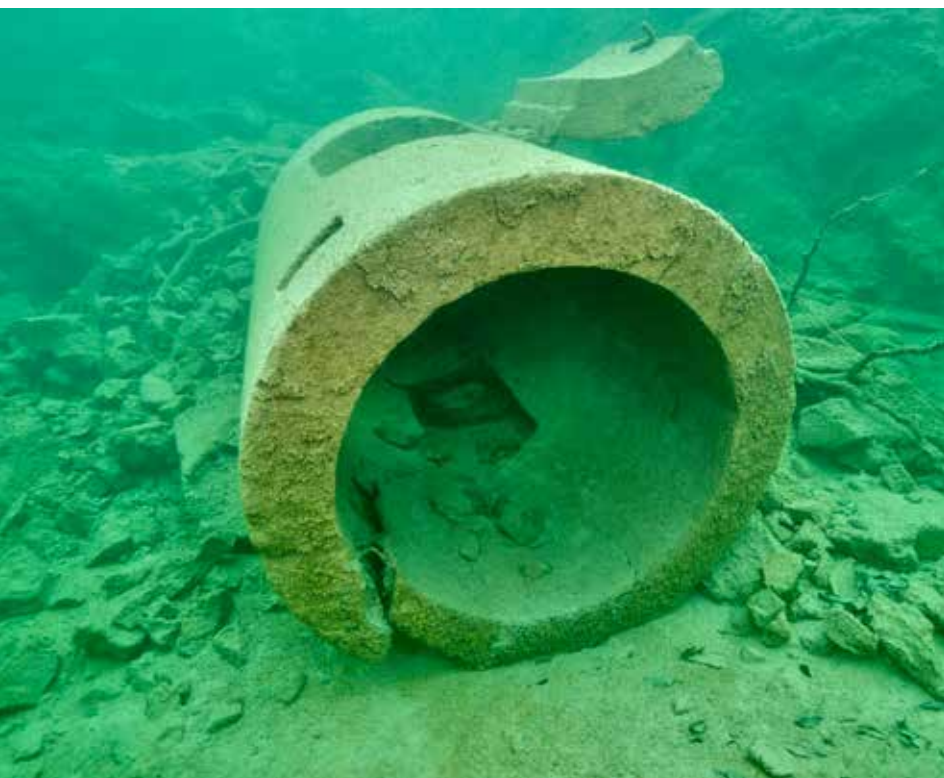
Der Einmannbunker im Walchensee in der Ausführung mit zwei gegenüberliegenden Schlupftüren, wobei die zweite Tür bei eventuellen Verschüttungen als Notausstieg gedacht war.
