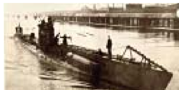
Historische Postkarte mit dem U-Boot UC 71, vorne über dem Bug die auffällige Netzsäge.
